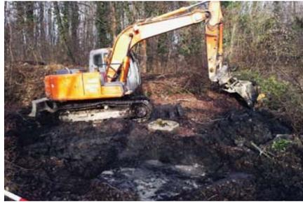
Biotop wurden ebenfalls die notwendigen Baumschnitte durchgeführt. An dieser Stelle Danke an alle Beteiligten. Die Baggerarbeiten haben am 1. Dezember begonnen. Mit einem 14t-Bagger wurde die Schlammschicht im Biotop abgehoben und mit einem Dumper zum Bereich beim Handymast zwischenverführt, anschließend abtransportiert. Die Baggerarbeiten sind auch noch im Dezember abgeschlossen worden.
